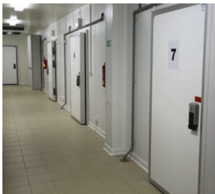
Obr. 1: Chladové komory genové banky
