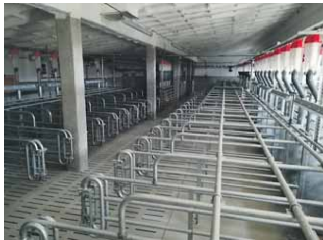
Porodní kotce jsou vybaveny plastovými rošty, plastovými vanami se špuntovým systémem vypouštění kejdy.
