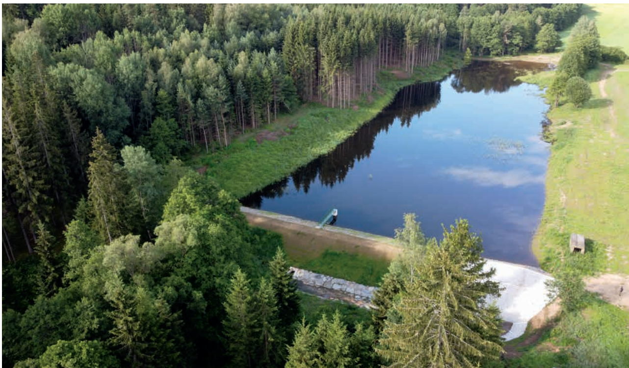
Vodní nádrž Jaroměř u Kaplice (zdroj: LČR)
