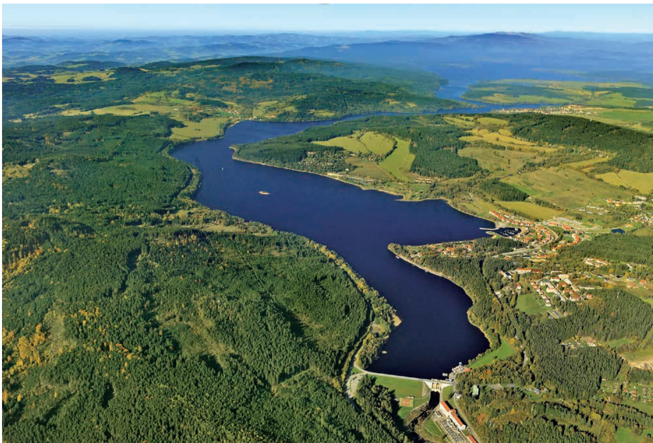
Vodní dílo Lipno I (zdroj: Povodí Vltavy)
