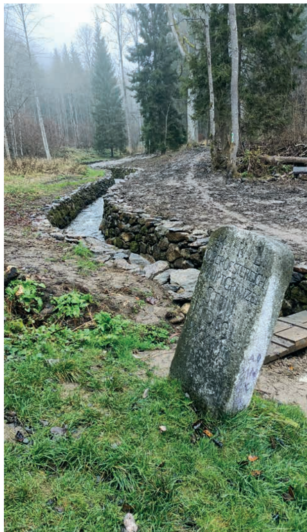
Opevnění toku Světlá na Českokrumlovsku (zdroj: LČR)
