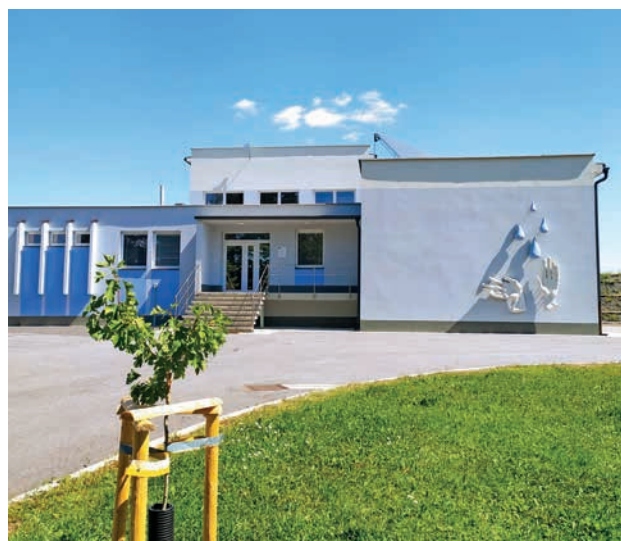
Úpravna vody Lázně Bělohrad (autor: Hubalová Petra)
