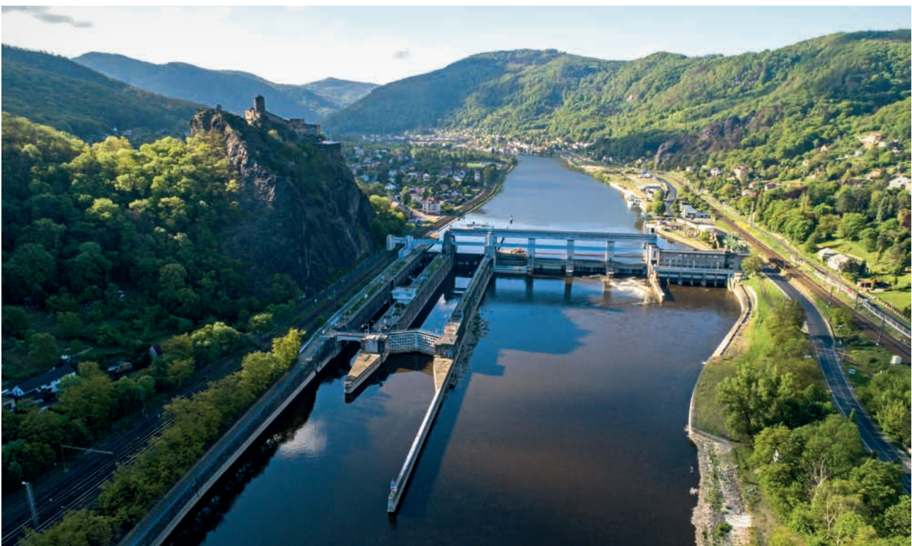
Zdyadlo Střekov (zdroj: Povodí Labe)
