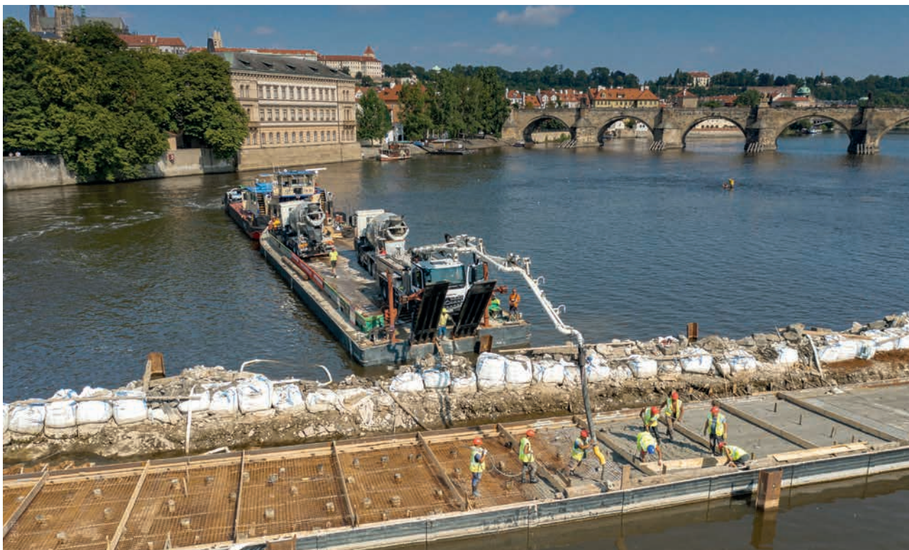
Staroměstský jez betonáž (zdroj: Povodí Vltavy)
