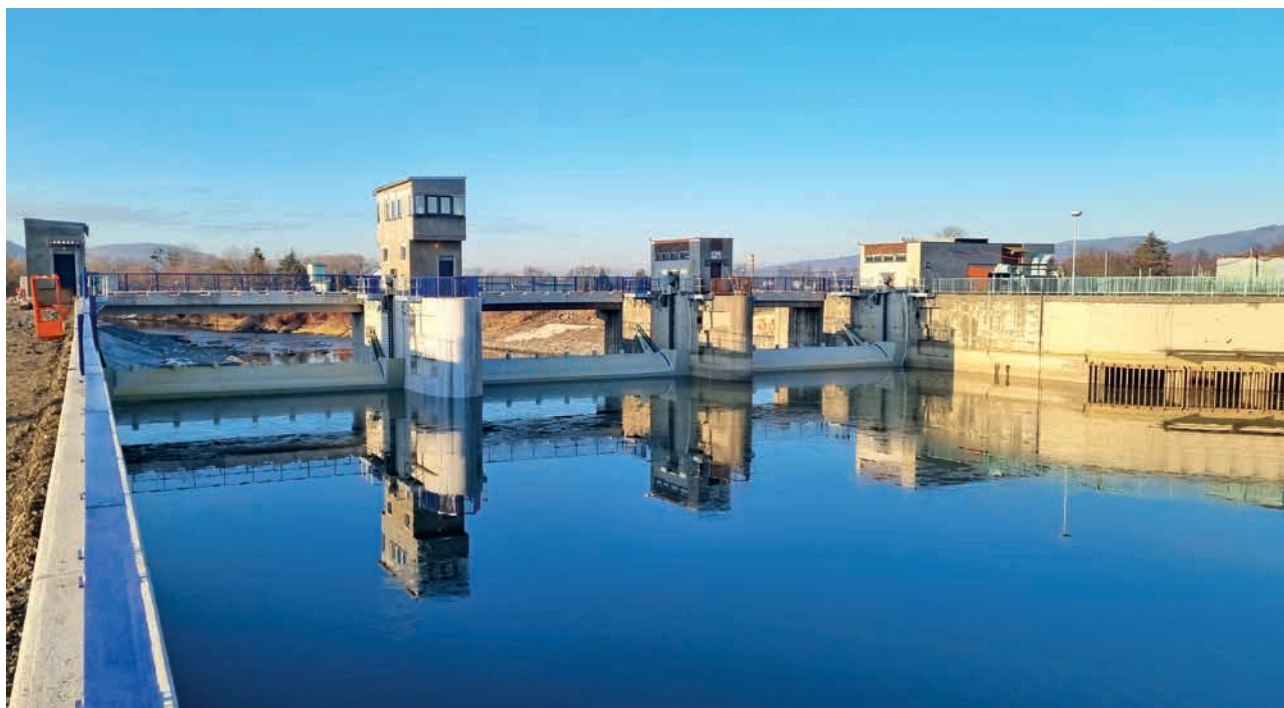
Rekonstrukce jezu Hranice (zdroj: Povodí Moravy)
