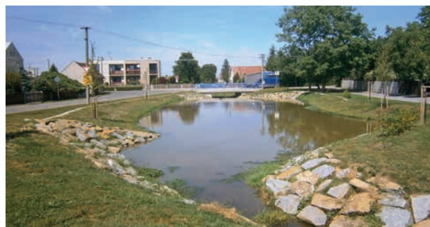
Protipovodňové opatření na Markovickém potoce v Pardubické kraji (zdroj: LČR)
