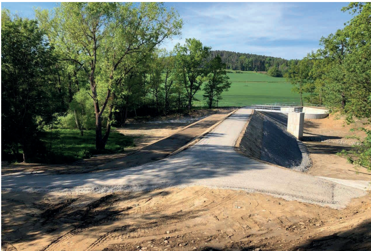
Bavorovský potok, MVN Přehrada Bavorov – rekonstrukce nádrže a odbahnění nádrže – stav po opravě (autor: Bušek Jan)
