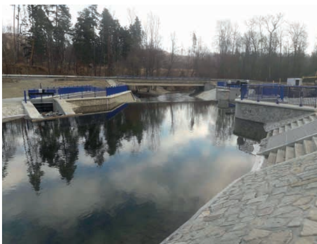
Jez Kunov na řece Opavě (zdroj: Povodí Odry)
