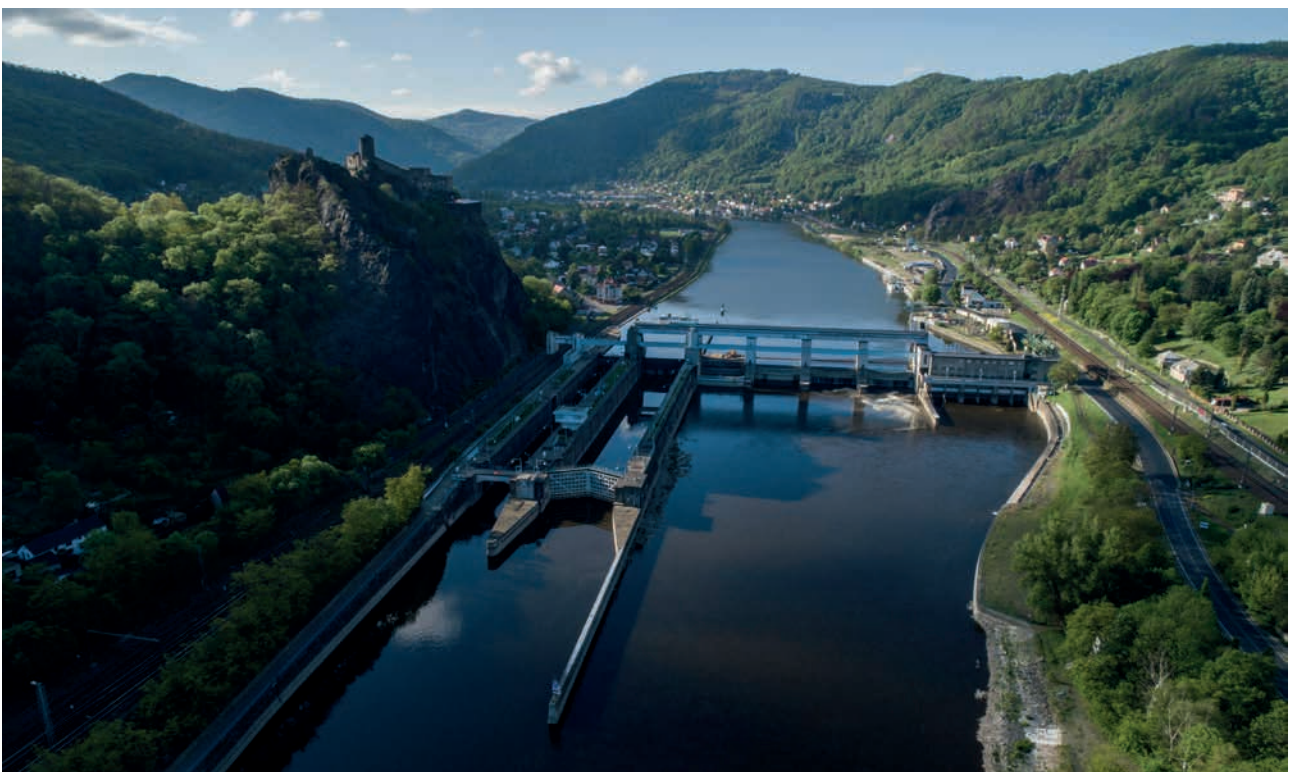
Zdyadlo Střekov (zdroj: Povodí Labe)
