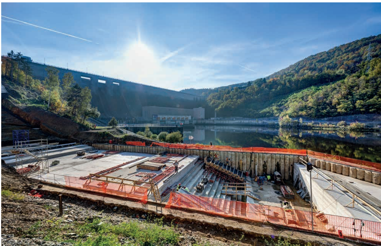
VD Orlík – Realizace zkušební bloku betonáže (zdroj: Metrostav a. s.)
