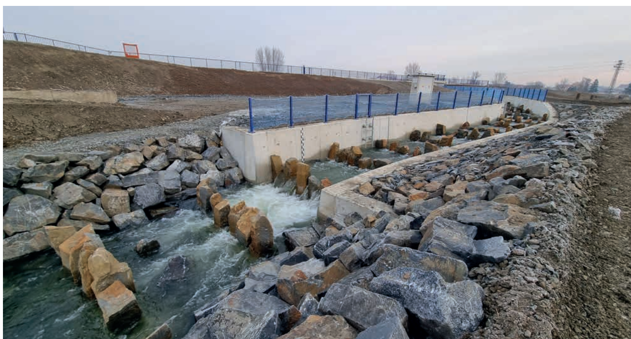
Rekonstrukce jezu Hranice – rybí přechod (zdroj: Povodí Moravy)
