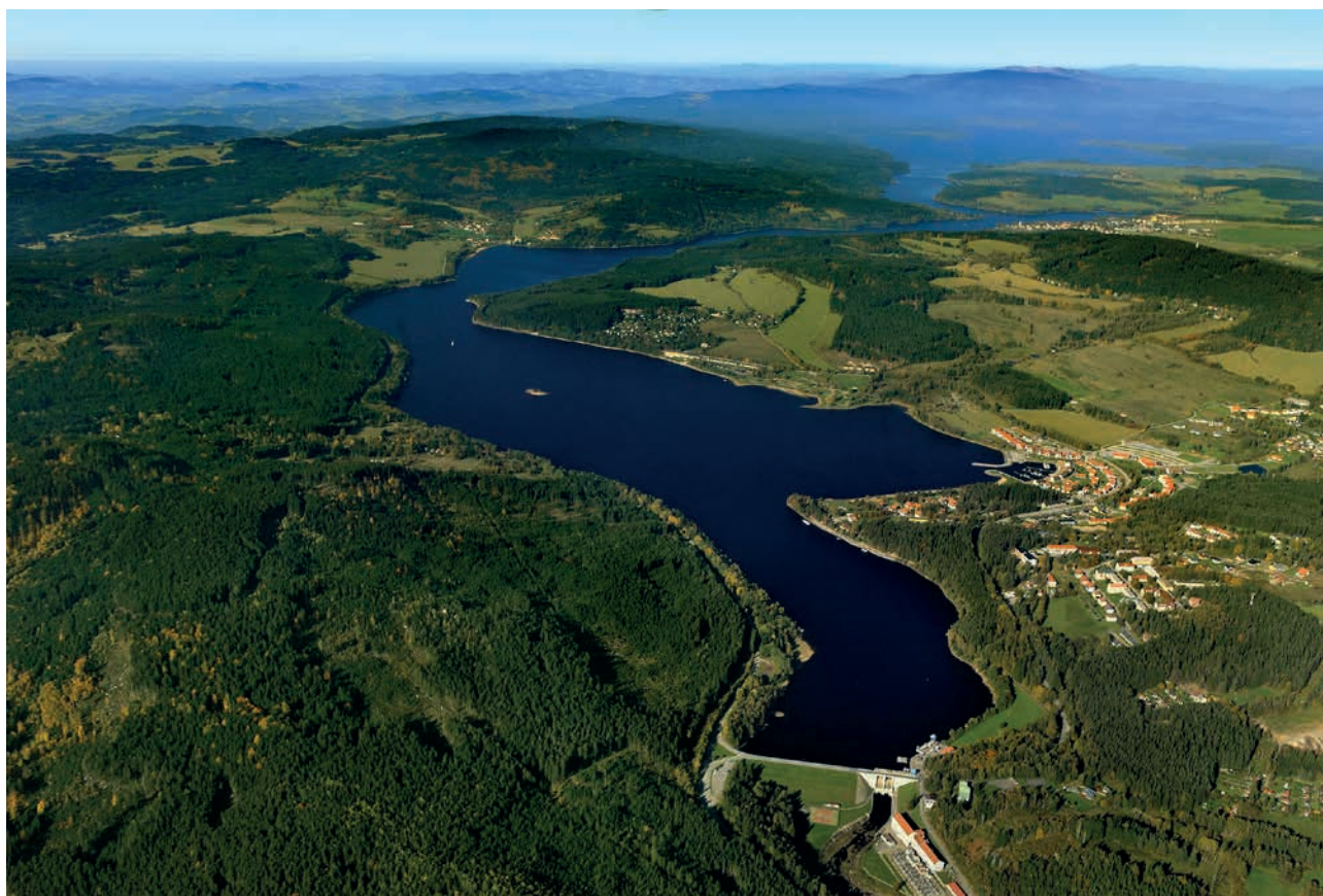
Vodní dílo Lipno I (zdroj: Povodí Vltavy)
