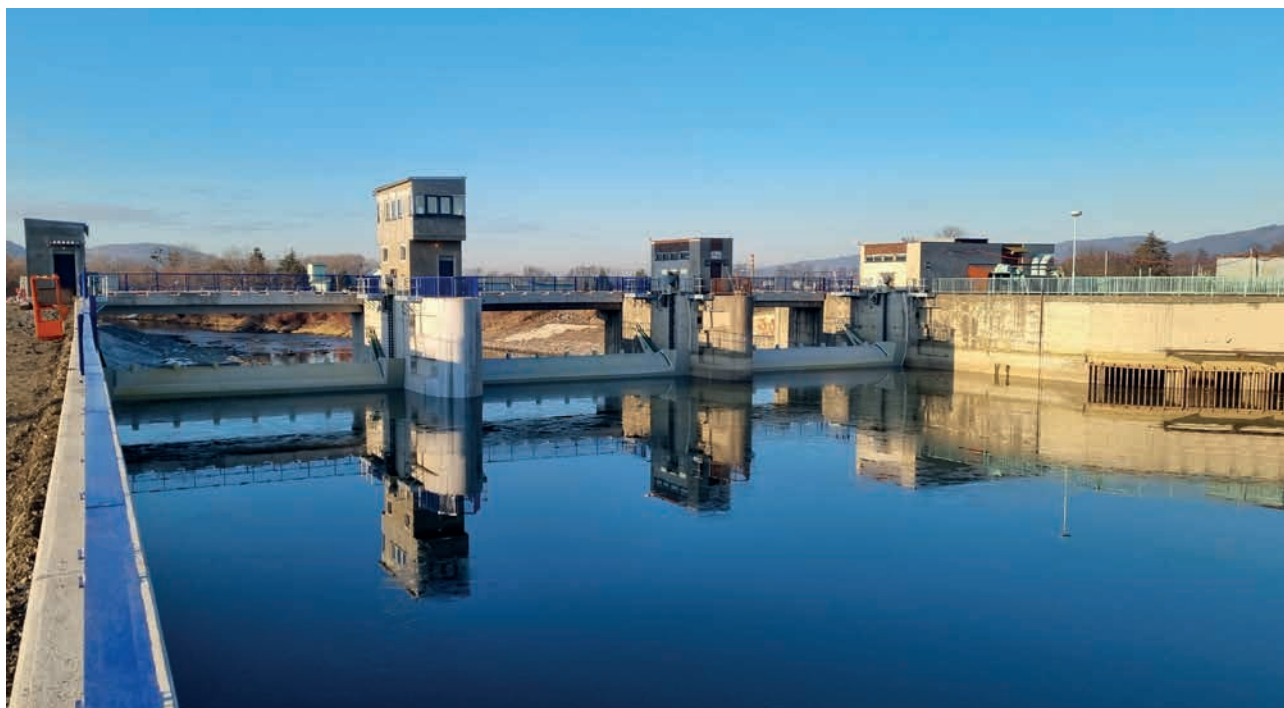
Rekonstrukce jezu Hranice (zdroj: Povodí Moravy)
