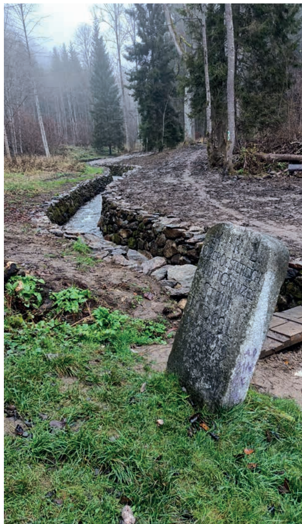
Opevnění toku Světlá na Českokrumlovsku (zdroj: LČR)
