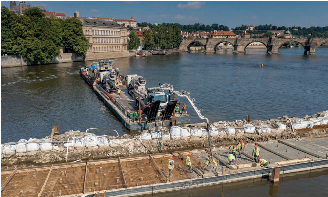
Staroměstský jez betonáž (zdroj: Povodí Vltavy)
