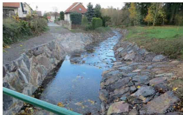
DVT Mourový potok, Zaječov – stabilizace koryta, stav po opravě (autor: Žáčková Anna)
