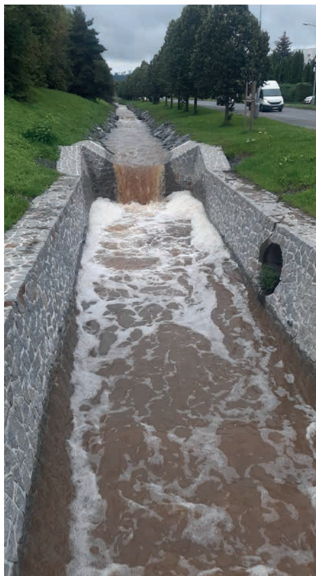
Opevnění Rakovského potoka v obci Rokycany (zdroj: LČR)
