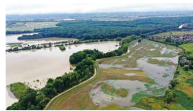
Rohatec, Jihočeský kraj - protipovodňová hráz - Hráz je 1,5 km dlouhá a ca 3 m vysoká a pojme tzv. stouletou vodu. Bez tohoto opatření by se opakovala situace z let 1997, 2006 a 2010.
